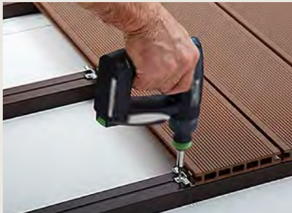
kompozytowe za pomocą klipsów
