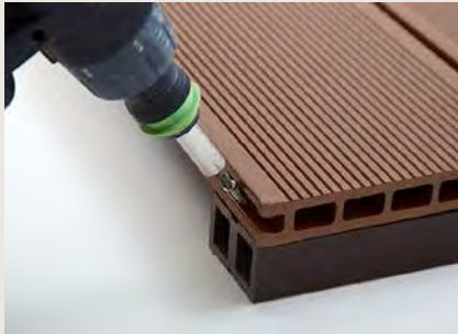
zamocuj listwy brzegowe za pomocą wkrętów
