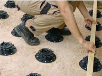
wyrównaj ustawienie legarów na wspornikach
